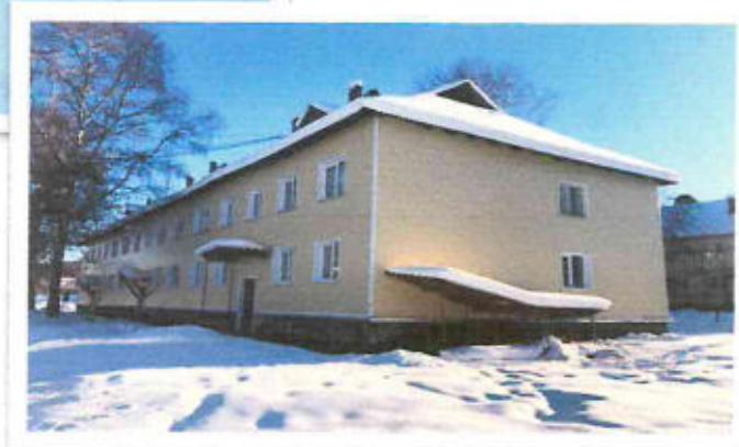
Рис. 2 После ремонта фасада, г. Байкальск, мкр. Южный, 4-й кв-л., д. 7
