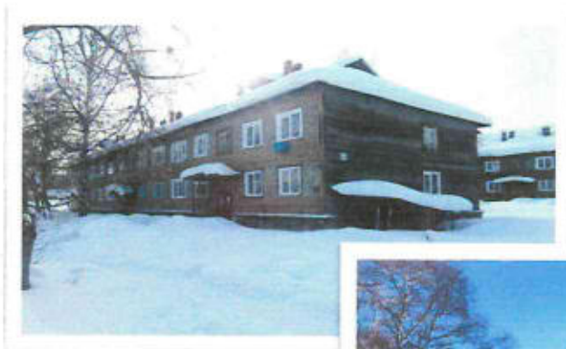
Рис. 1 До ремонта фасада, г. Байкальск, мкр. Южный, 4-й кв-л., д. 7
